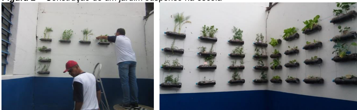
Figura 2 – Construção de um jardim suspenso na escola
