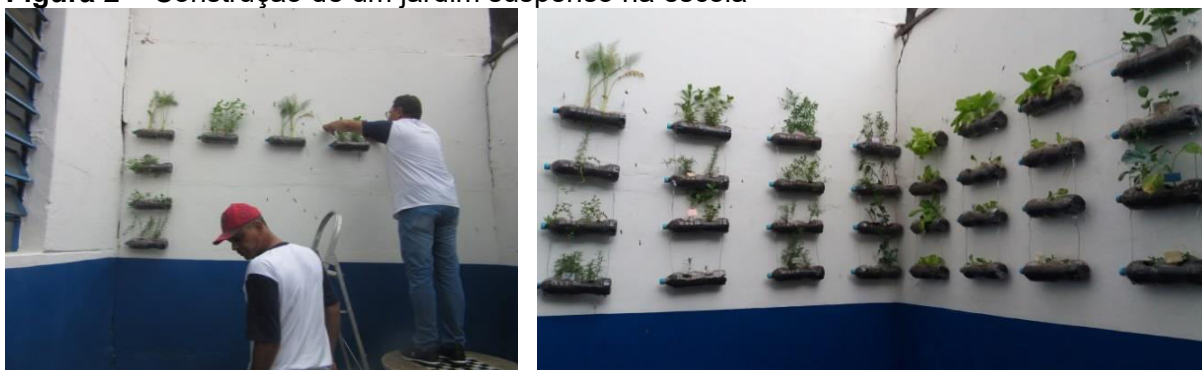
Figura 2 – Construção de um jardim suspenso na escola
